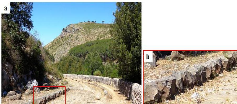
Fig. 9 – (a) Assetto della Via Appia dopo il rifacimento borbonico; (b) Dettaglio dei basoli vulcanici, di epoca romana, riutilizzati per il contenimento della strada borbonica.
