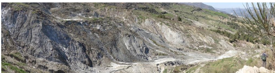
Fig. 2 - Il fianco destro dell'area di alimentazione della frana del Vomice.
