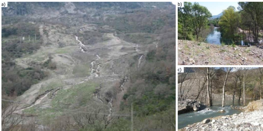
Fig. 3 - Alcuni particolari della Frana di Zillona: a) il corpo di frana in corrispondenza del canale della colata; b) lago di frana a monte dello sbarramento nel 2007; c) fasi di svuotamento del lago di frana.
