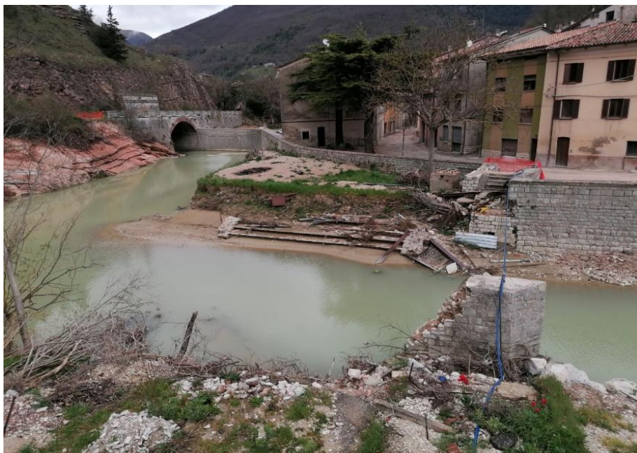
Fig. 4 - Sullo sfondo l'imbocco della galleria di derivazione del F. Burano e in primo piano le case del quartiere che sono state coinvolte fin dalla prima fase dall'esondazione in questa zona.
