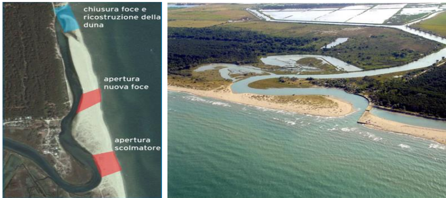
Fig. 3 - Sistemazione di Foce Bevano: schematizzazione dei principali interventi eseguiti e foce attuale.
