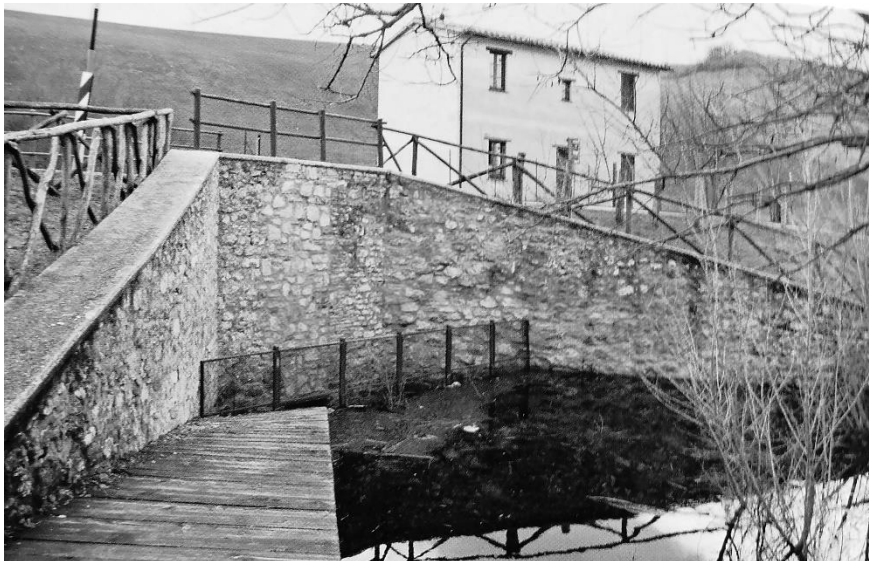
Le acque della palude subito a monte della paratoia con griglia per trattenere i materiali flottanti. Sullo sfondo la casa del mugnaio («mollaro»), ridotta a ruderi dal sisma del 1997, poi ricostruita nel rispetto della volumetria e delle strutture murarie caratteristiche del manufatto.
