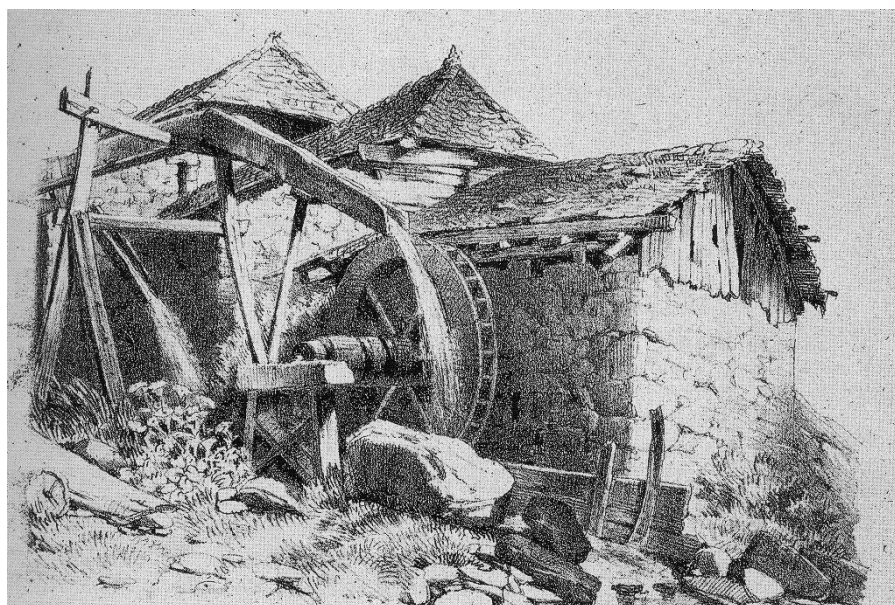
Fig. 4 – Mulino con doccia e ruota a copedello da una incisione del sec. XIX (fonte: Grandis C., 2001).
