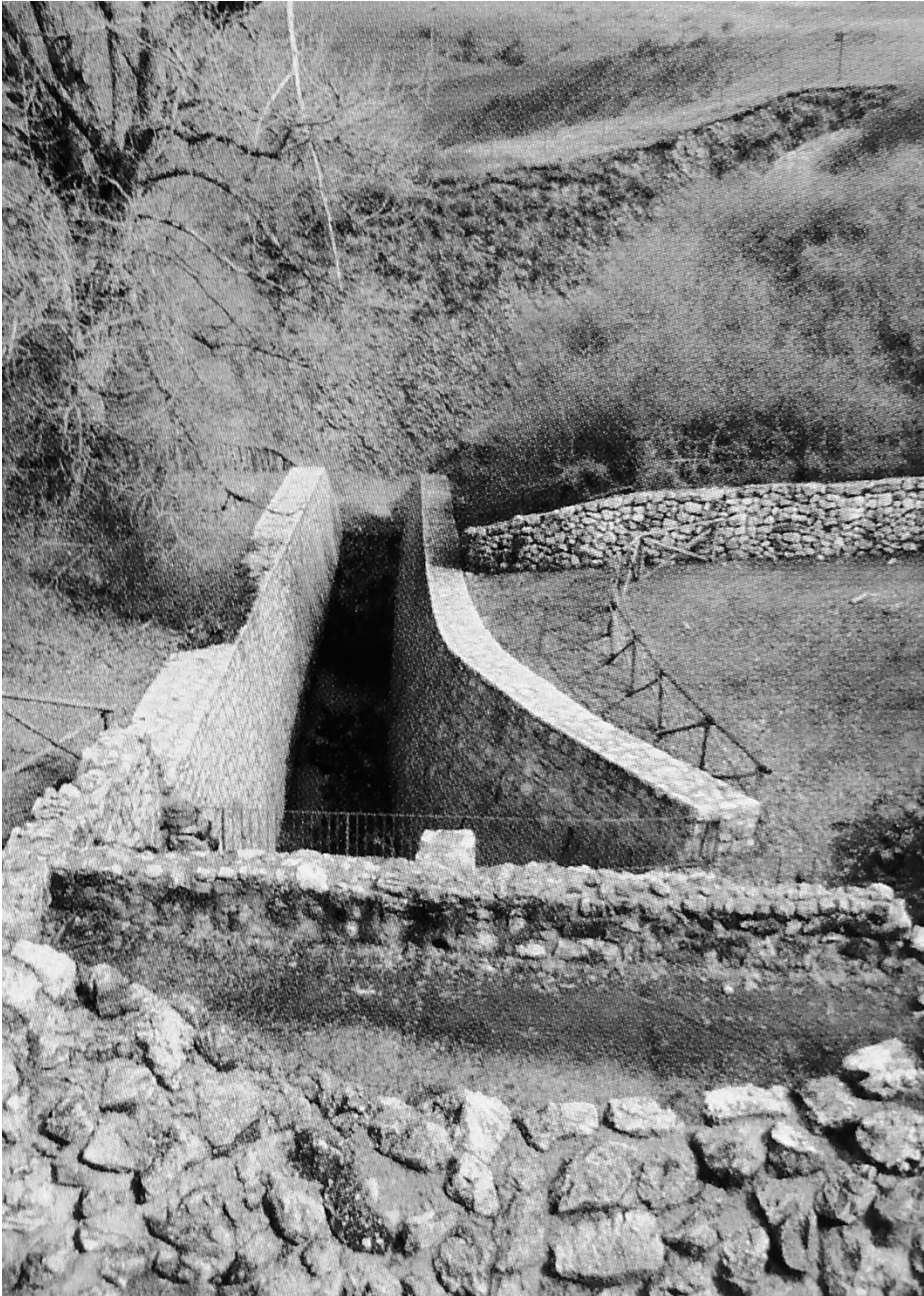
Il canale di scarico e sul fondo l'inghiottitoio
