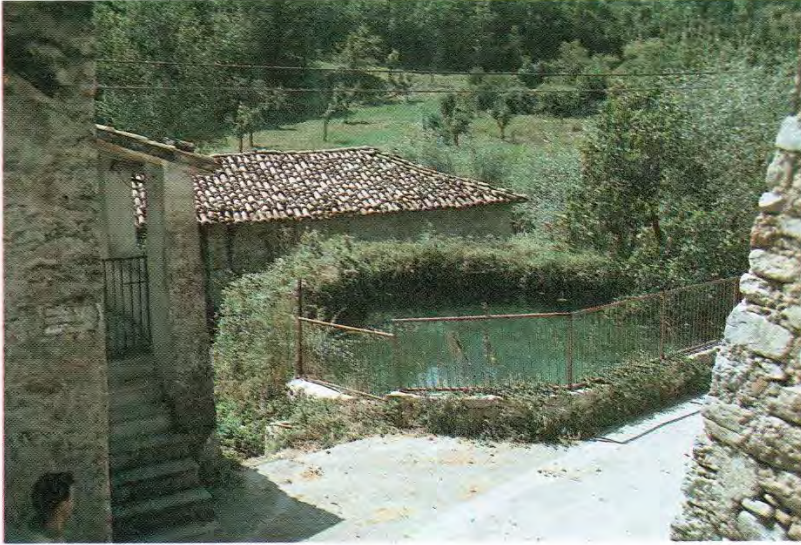
Foto 16 – L'«accota» (vasca di carico) del mulino di Pontuglia , nei pressi di Ceselli, in Valnerina. Da qualche anno le macine sono ferme ma gli impianti si conservano bene: un caso idoneo a realizzare un'iniziativa di archeologia industriale?
