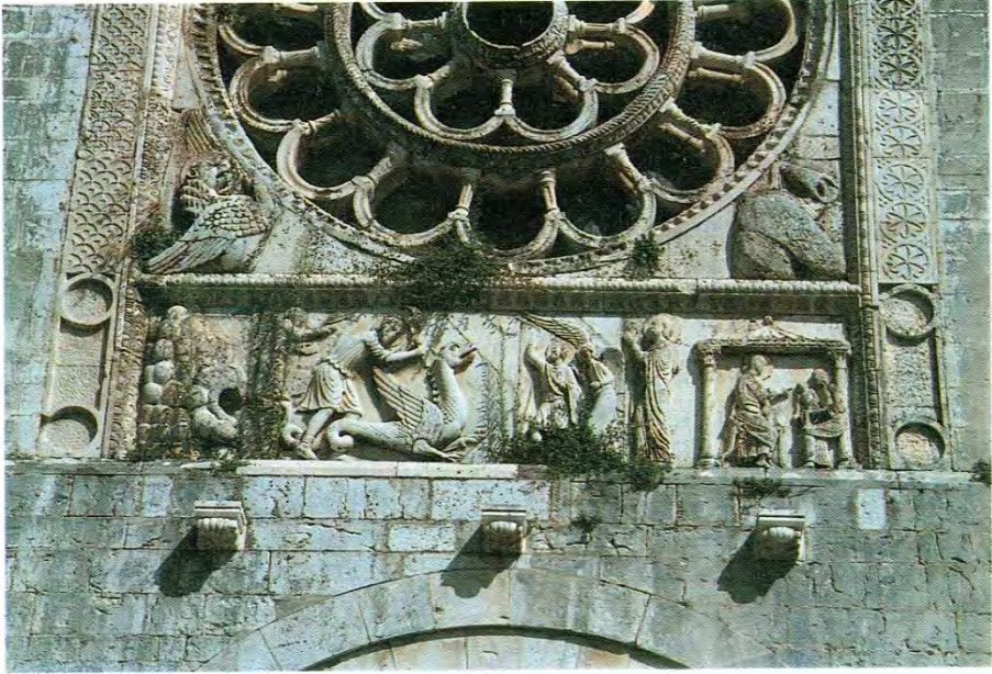
Foto 4 – Chiesa di S. Felice di Narco, presso S. Anatolia. Nel bassorilievo sottostante il rosone della bellissima facciata (sec. XII) è metaforicamente ricordata la bonifica della valle attraverso l'uccisione del «drago» (F. Nera) ad opera dei santi Felice e Mauro.
