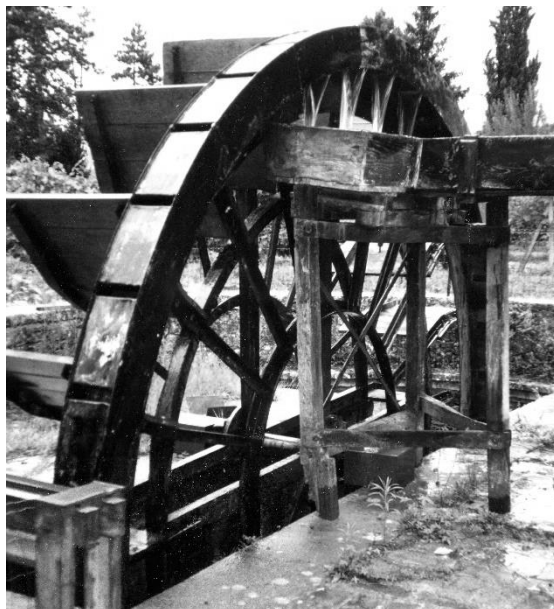
Fig. 5 – Lungo i canali di adduzione al bacino di carico dei mulini si installavano talvolta macchine a noria per irrigare i campi prossimi al mulino (foto A. Melelli).
