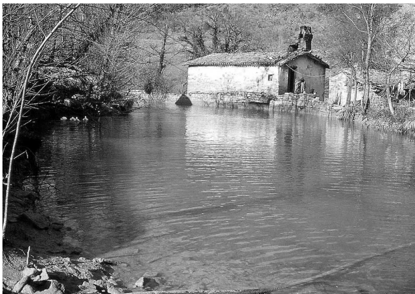
Fig. 6 – L' accolta (bacino di carico) del Mulino di Valentino, ancora funzionante e aperto alla visita, situato lungo un fosso tributario del Fiume Topino (Valtopina, Umbria) (foto A. Melelli).
