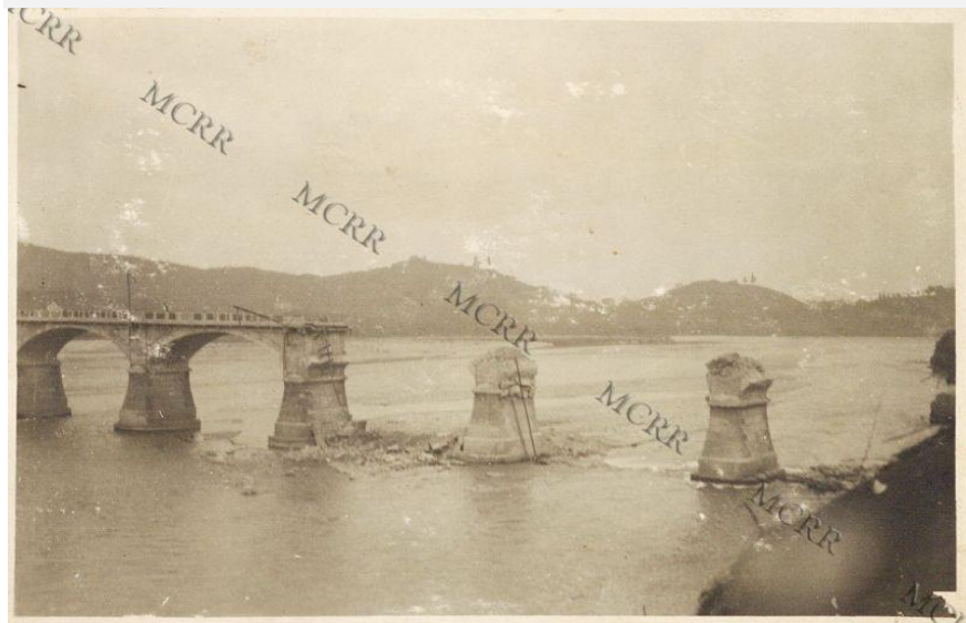
Ponte Vidor abbattuto
