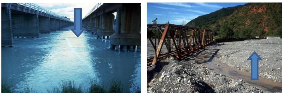
Fig. 11 – A sinistra: l'alveo è in approfondimento (i piloni del ponte sono scalzati e la nuova opera, a sinistra nella stessa foto, sta subendo ancora il medesimo processo). A destra: l'alveo è in sedimentazione (in aggradazione) e la luce del ponte è stata rapidamente occlusa per l'enorme apporto solido. Foto: Paolo Tacconi.
