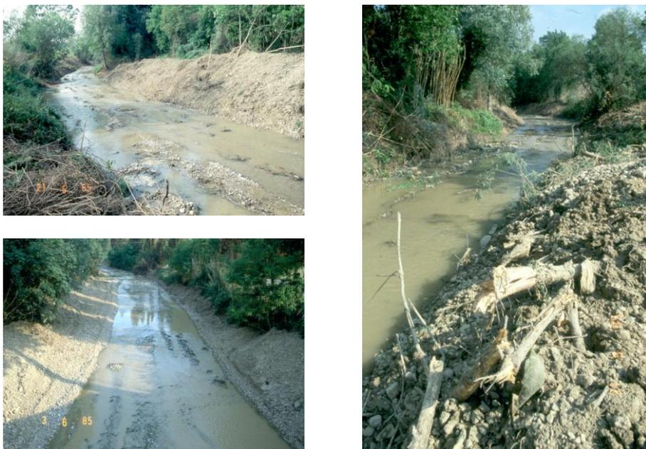
Fig. 22 – Lavori di “sistemazione idraulica” nell’alveo del T. Virginio (bacino del F. Pesa, Toscana). L’alveo è stato ridotto a uno stato che non ha nulla a che vedere con quello di un alveo naturale: sponde simmetriche, con circa  $45^\circ$  gradi di pendenza; fondo piatto e allargato (tra l’altro estraendo materiale inerte, ammassato al di là delle sponde). Foto: Paolo Tacconi.
