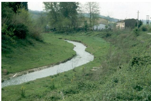
Fig. 23 – La “reazione” del fiume, a circa un anno dall’ultimazione dei lavori. Si nota come il corso d’acqua stia cercando di riacquistare la conformazione originaria del tracciato, incidendo la porzione d’alveo che era stata “sistemata”. Foto: Paolo Tacconi.
