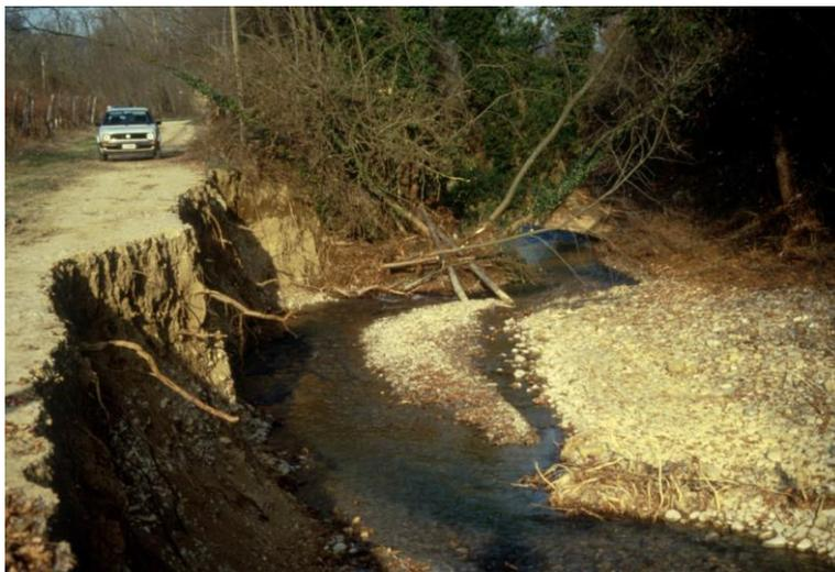
Fig. 16 – Una strada franata per erosione di sponda nel T. Virginio (bacino del F. Pesa). Foto: Paolo Tacconi
