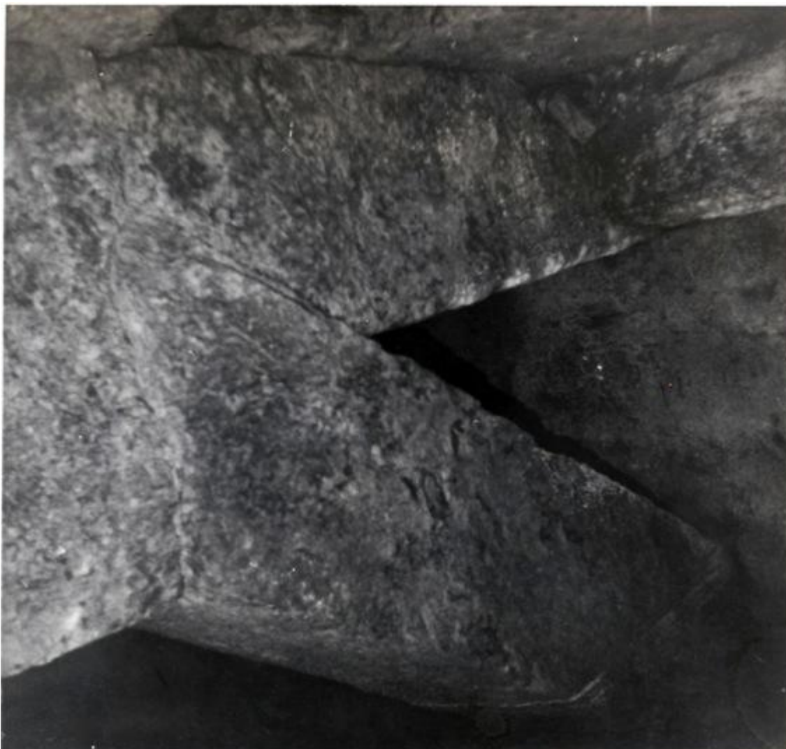
Fig. 10.2 – Foto delle capriate di copertura del Pozzo Etrusco, prima che la cavità venisse svuotata artificialmente. Si nota il livello dell’acqua fino alla base dei blocchi di travertino.
