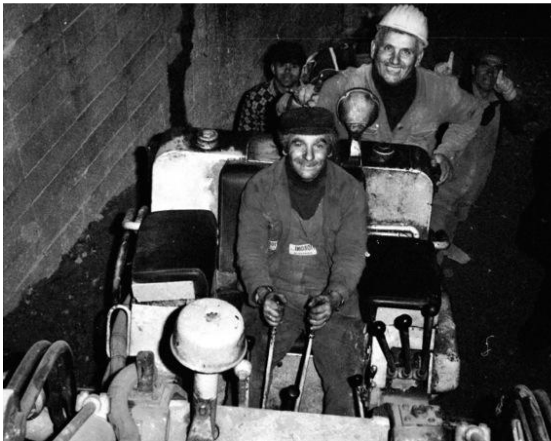
Fig. 26.6 – Fasi di esecuzione della scala mobile al di sotto della Rocca Paolina (anni '80).
