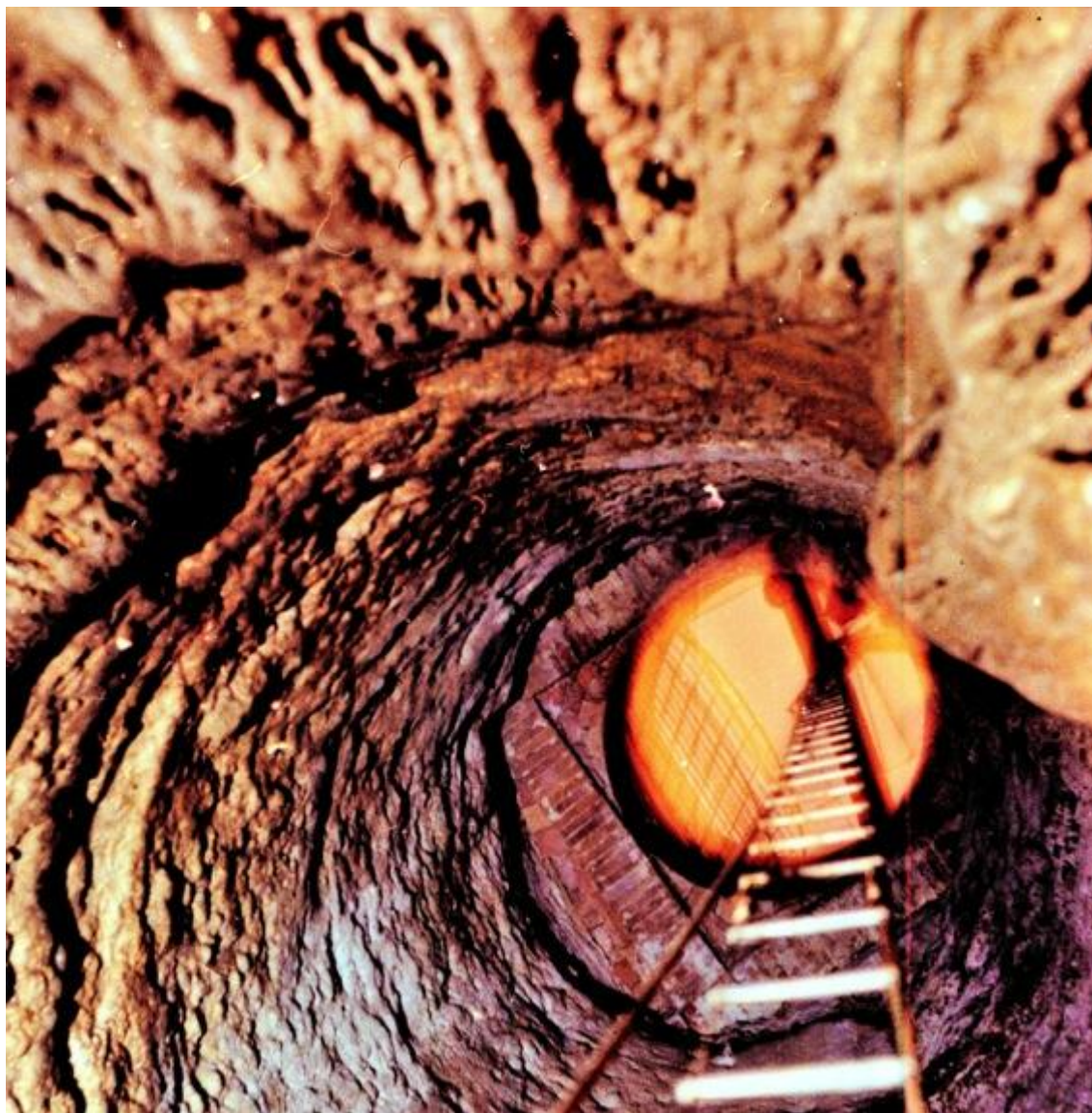
Fig. 31.2 – Documentazione fotografica dell'attività esplorativa del pozzo n. 31, presso il Chiostro del Pozzo o del Capitolo. Anche in questa immagine, in primo piano e in alto, sono visibili le concrezioni calcaree lungo le pareti del pozzo.
