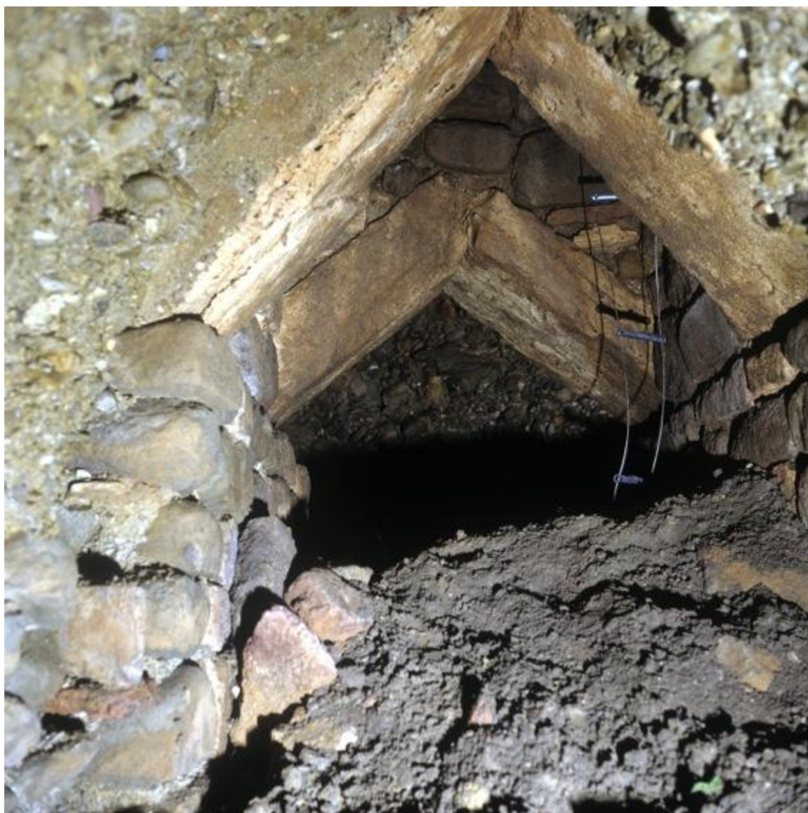
Fig. 17.1 – Documentazione fotografica dell'attività esplorativa del cunicolo n. 17, presso Piazza Cavallotti.
