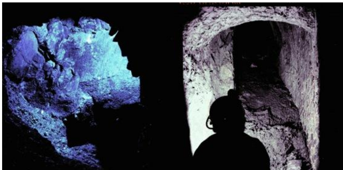
Fig. 25.2 – Documentazione fotografica dell'esplorazione del cunicolo n. 25 ubicato lungo la prima traversa sulla destra (come indicato da disegno originale) di Via Cesare Caporali. La scarsa qualità delle immagini non consente una corretta determinazione del tipo di terreno sebbene si possa intuire una natura grossolana dei depositi.
