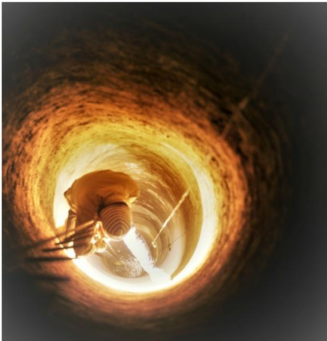
Fig. 26.5 – Fase del rilevamento, nel 1980, dei pozzi all'interno della Rocca Paolina.
