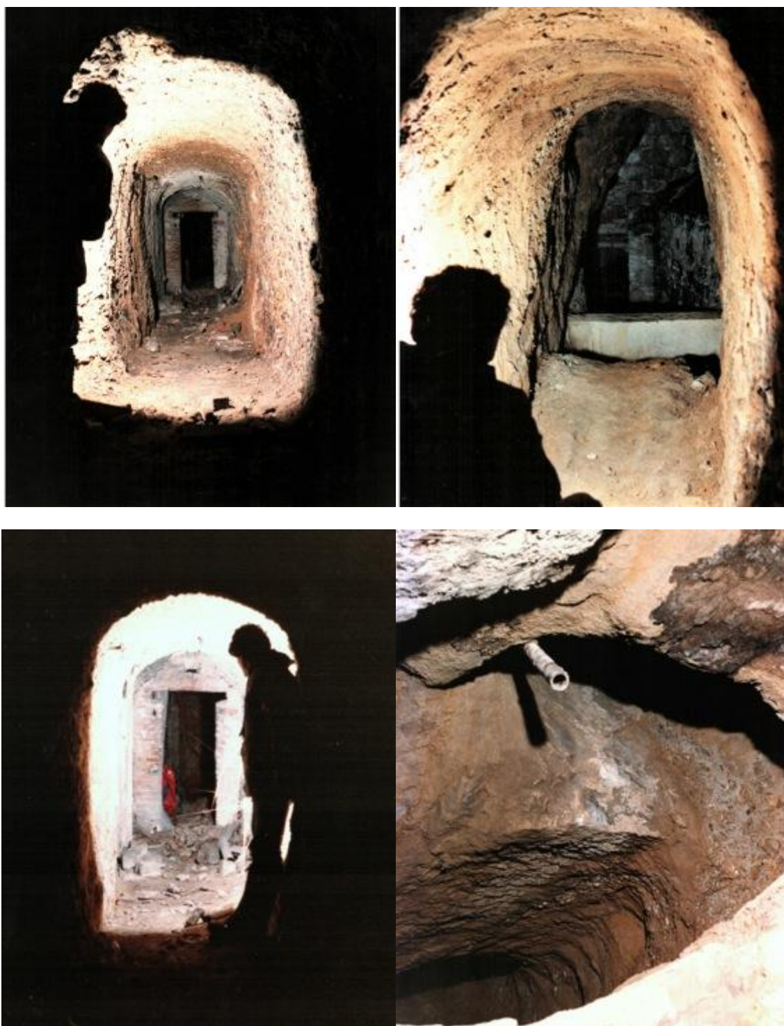
Fig. 1.3 – Documentazione fotografica dell'attività esplorativa del cunicolo n. 1, nei pressi dell'Arco Etrusco.
