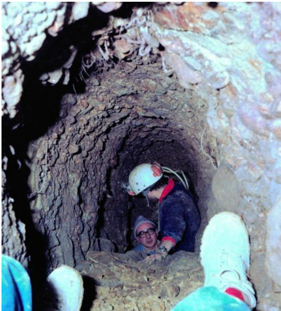
Fig. 26.4 – Fase del rilevamento del cunicolo sottostante la Rocca Paolina individuato durante la costruzione della scala mobile tra Piazza Partigiani e Piazza Italia, all'incrocio con Viale Indipendenza nel 1982. In primo piano, il terreno naturale con granulometria dei clasti prevalentemente grossolana. In foto, Guido Lemmi.
