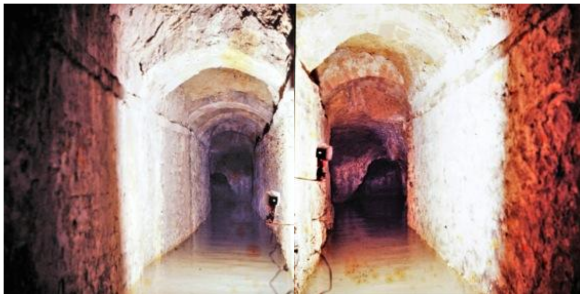
Fig. 6.2 – Documentazione fotografica dell'attività esplorativa in data 18 giugno 1977 del cunicolo n. 6, presso la Scuola dell'Infanzia Santa Croce.
