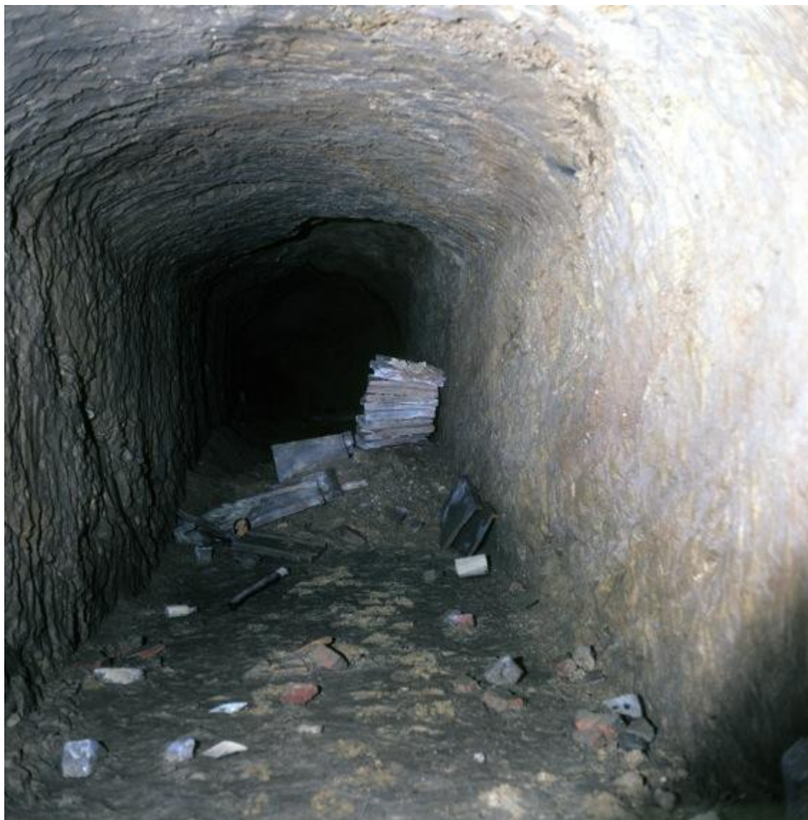
Fig. 3.2 – Documentazione fotografica dell'attività esplorativa del cunicolo n. 3, lungo Viale Sant'Antonio. In evidenza, il terreno di scavo a prevalente frazione fine.
