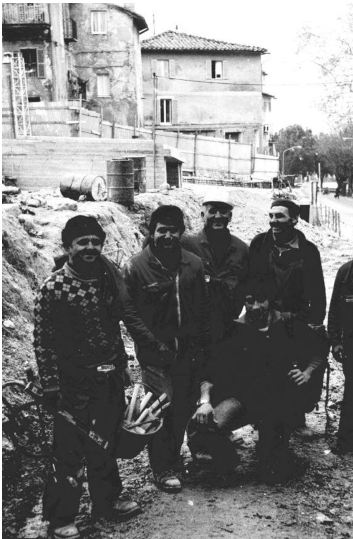
Fig. 26.7 – Fasi di esecuzione della scala mobile al di sotto della Rocca Paolina (anni '80).
