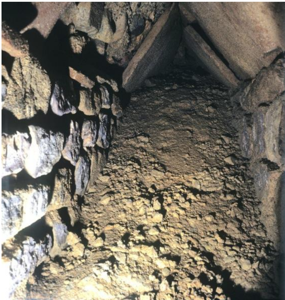
Fig. 17.3 – Documentazione fotografica dell'attività esplorativa del cunicolo n. 17, presso Piazza Cavallotti.
