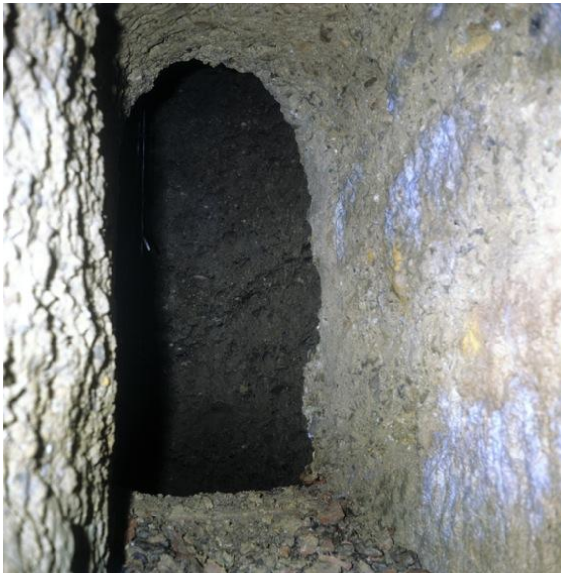
Fig. 7.5 – Documentazione fotografica dell'attività esplorativa del cunicolo n. 7, in Piazza Biordo Michelotti. I depositi di scavo mostrano una granulometria grossolana e un assetto inclinato.
