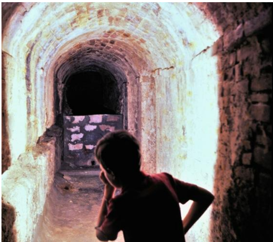
Fig. 6.3 – Documentazione fotografica dell'attività esplorativa in data 18 giugno 1977 del cunicolo n. 6, presso la Scuola dell'Infanzia Santa Croce.
