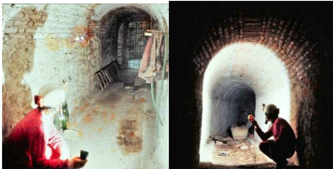
Fig. 27.2 – Documentazione fotografica dell'attività esplorativa del cunicolo n. 27, in data 21 giugno 1977 presso il Collegio Fatebenefratelli (rilievo R. Rosini, E. Rosati). Le immagini raffigurano il tratto iniziale rivestito in laterizi.
