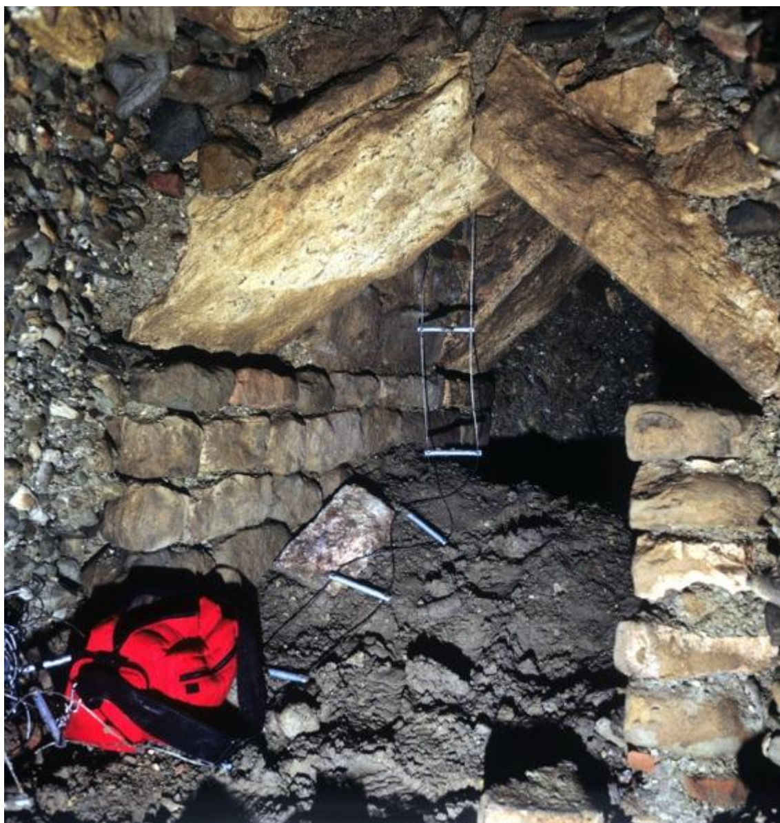
Fig. 17.2 – Documentazione fotografica dell'attività esplorativa del cunicolo n. 17, presso Piazza Cavallotti.
