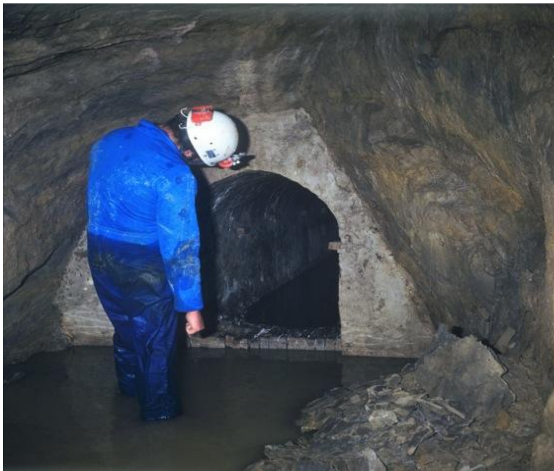
Fig. 4.3 – Documentazione fotografica dell'attività esplorativa della cavità n. 4, presso la chiesa di Santa Maria Nuova. In evidenza i depositi di scavo, apparentemente sabbie e argille. Dalla galleria si osserva l'imbocco a un cunicolo di dimensioni più ridotte.
