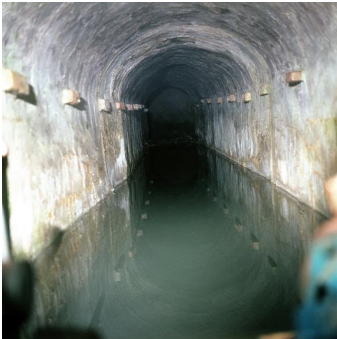
Fig. 4.4 – Documentazione fotografica dell'attività esplorativa della cavità n. 4, presso la chiesa di Santa Maria Nuova. L'imbocco è ripreso nella foto di fig. 4.3.
