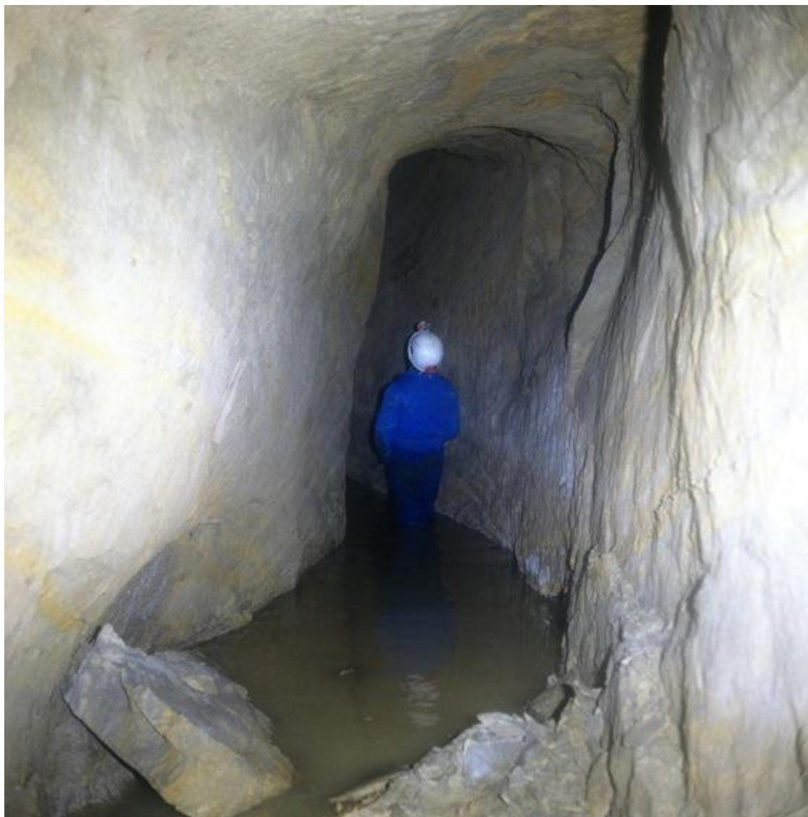
Fig. 4.5 – Documentazione fotografica dell'attività esplorativa della cavità n. 4, presso la chiesa di Santa Maria Nuova. Si notino i depositi di scavo, apparentemente sabbie e argille, e le notevoli dimensioni della cavità in verticale. Si apprezza un assetto debolmente inclinato dei depositi.
