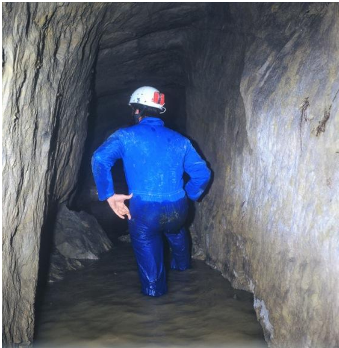
Fig. 4.2 – Documentazione fotografica dell'attività esplorativa della cavità n. 4 presso la chiesa di Santa Maria Nuova. In evidenza, i depositi di scavo, apparentemente sabbie e argille.
