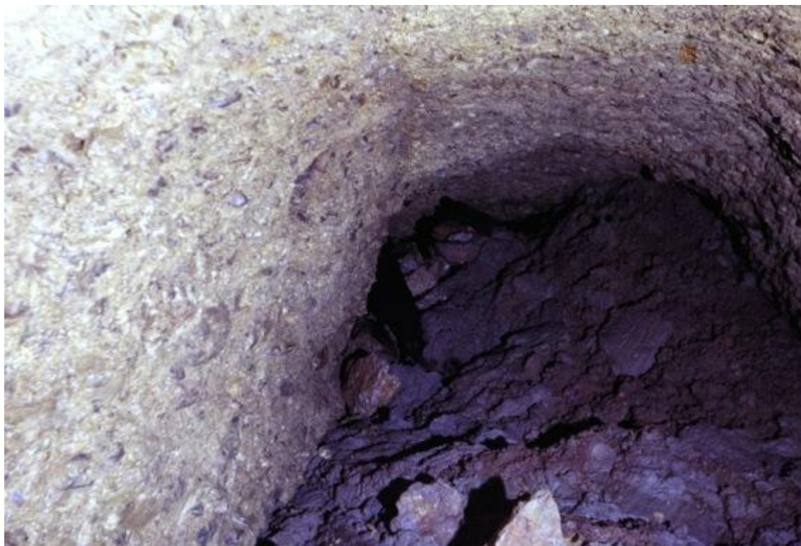
Fig. 27.4 – Documentazione fotografica dell'attività esplorativa in data 21 giugno 1977 del cunicolo n. 27 presso il Collegio Fatebenefratelli (rilievo R. Rosini, E. Rosati). L'immagine evidenzia la natura granulometrica grossolana dei terreni di scavo.
