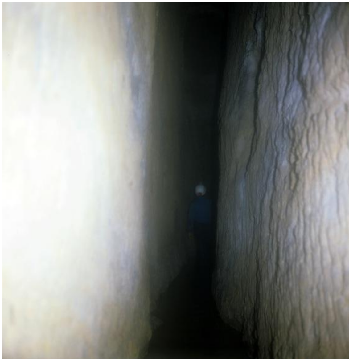
Fig. 4.7 – Documentazione fotografica dell'attività esplorativa della cavità n. 4, presso la chiesa di Santa Maria Nuova. In evidenza i depositi di scavo, apparentemente sabbie e argille. Notevole è lo sviluppo in verticale del cunicolo.
