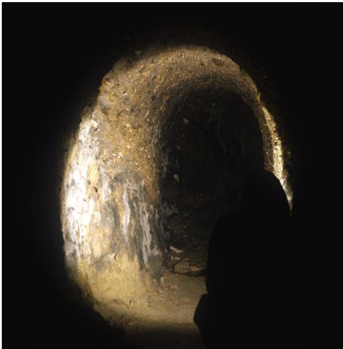
Fig. 20.3 - Il cunicolo della cavità n. 20, presso il locale "Il Cantinone" in Via Ritorta. In evidenza, i depositi in posto del colle con assetto molto inclinato e con una frazione grossolana conglomeratica nella parte alta della volta. Visibili, sul lato sinistro del cunicolo, il passaggio a sedimenti più fini, probabilmente sabbiosi.
