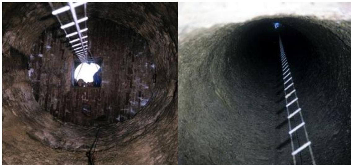
Fig. 7.3 – Documentazione fotografica dell'attività esplorativa del pozzo e del cunicolo n. 7, in Piazza Biordo Michelotti.
