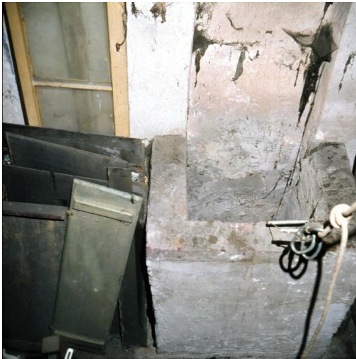
Fig. 9.2 – Documentazione fotografica dell'attività esplorativa in data 13 gennaio 1976 del pozzo n. 9, presso la Confraternita della Misericordia.
