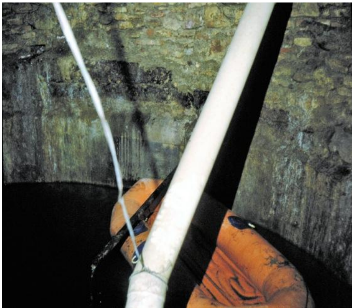
Fig. 23.2 – Documentazione fotografica dell'esplorazione della cisterna corrispondente alla cavità n. 23, all'interno del Garage "Galleria" in Via Santa Margherita, 2.
