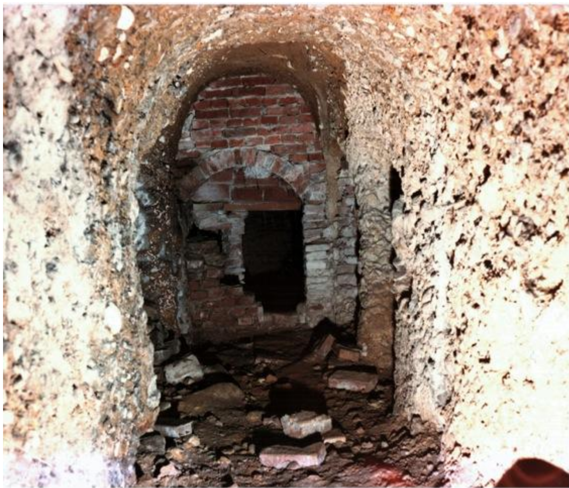
Fig. 1.5 – Documentazione fotografica dell'attività esplorativa del cunicolo n. 1, nei pressi dell'Arco Etrusco. In evidenza il terreno di scavo, a prevalente frazione grossolana.
