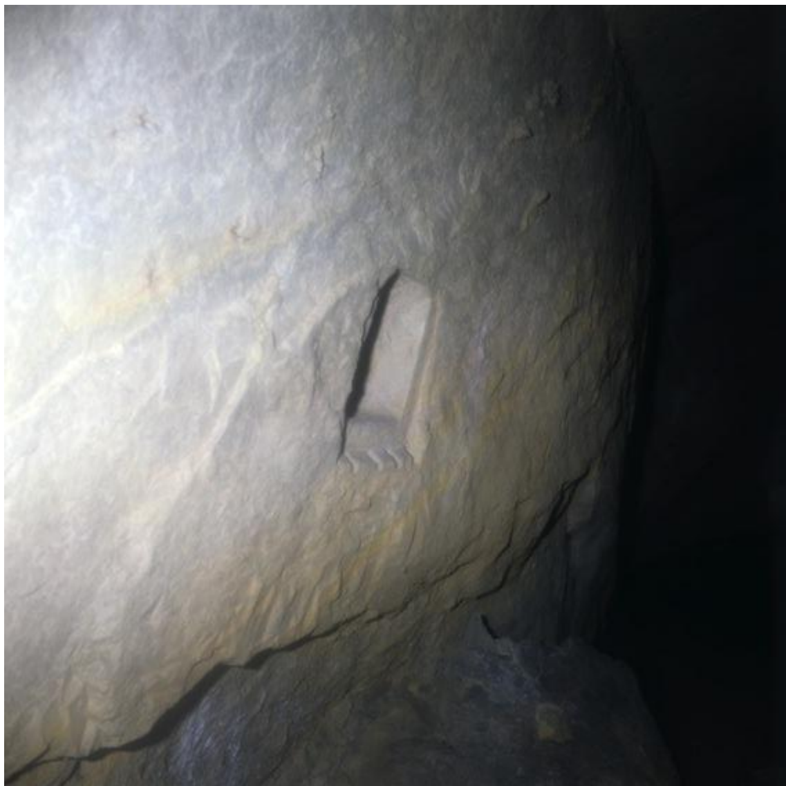
Fig. 4.6 – Documentazione fotografica dell'attività esplorativa della cavità n. 4, presso la chiesa di Santa Maria Nuova. In evidenza i depositi di scavo, apparentemente sabbie e argille. Si apprezza anche in questo caso un assetto debolmente inclinato dei depositi.
