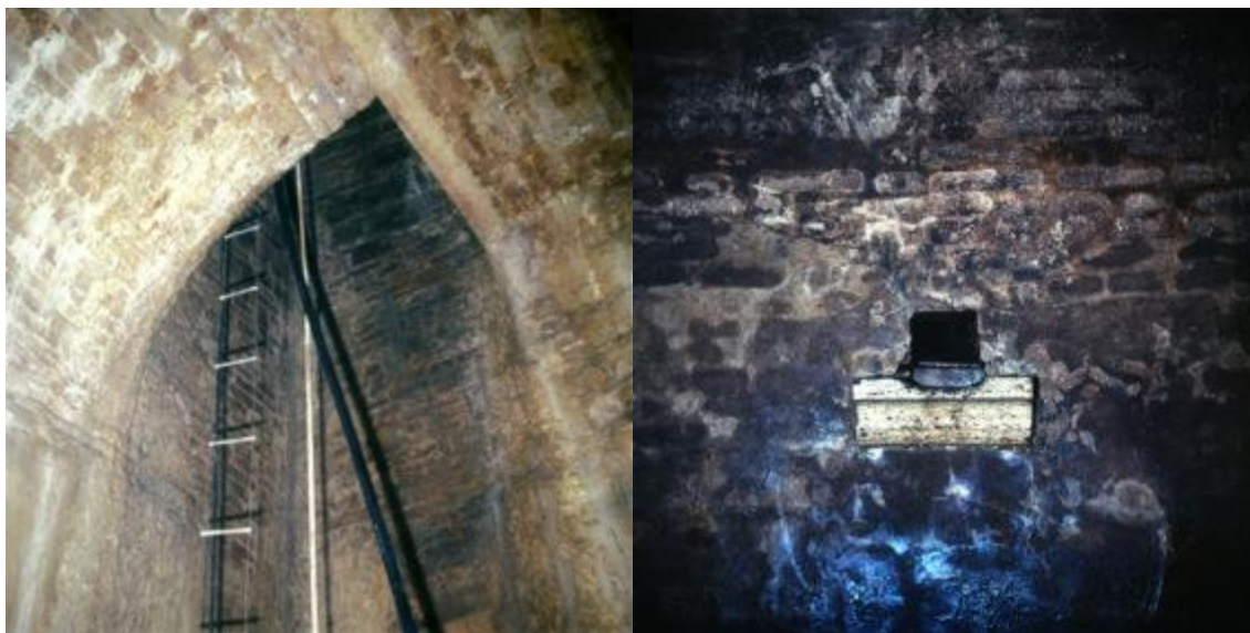
Fig. 22.1 – Documentazione fotografica dell'esplorazione della cisterna identificata come cunicolo n. 22, con accesso in prossimità di Via Danzetta.
